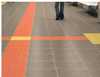
Уличные плитки монтируются в тротуар таким образом, чтобы они не являлись препятствием для пешеходов. Внутри помещений используют как встраиваемые, так и наклеивающиеся на половое покрытие плитки или отдельные тактильные элементы.
